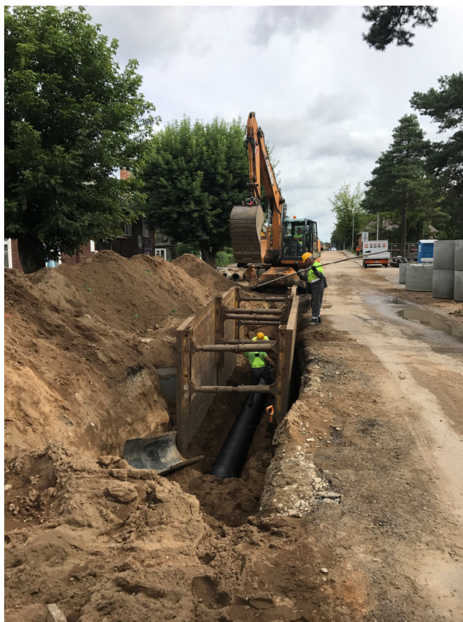
35 pav. 2017 m. J. Basanavičiaus g. magistralinio buitinių nuotekų tinklo rekonstravimas
