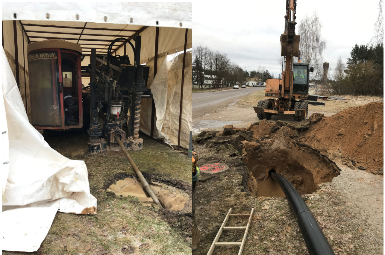
34 pav. 2017 m. J. Basanavičiaus g. magistralinių vandens tiekimo tinklų rekonstravimas
