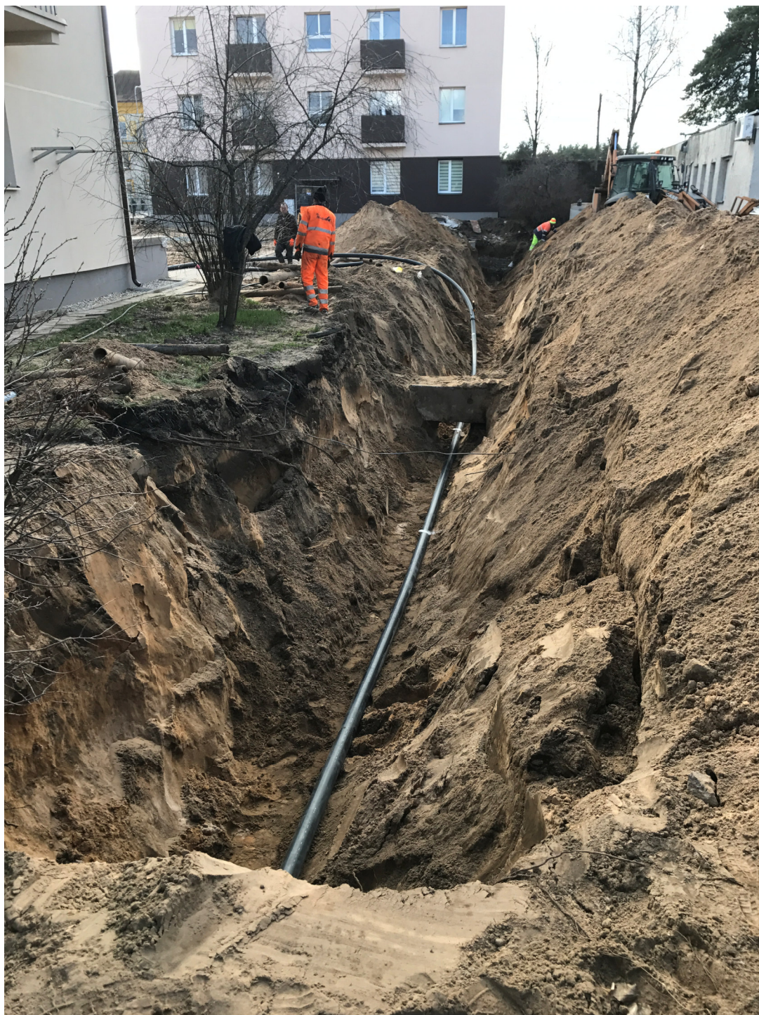
32 pav. 2017 m. Vasario 16-osios g. vandens tiekimo tinklų rekonstravimas
